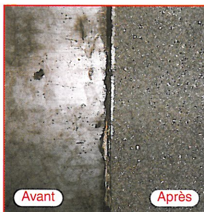
Préparation rugosité des sols intérieurs
