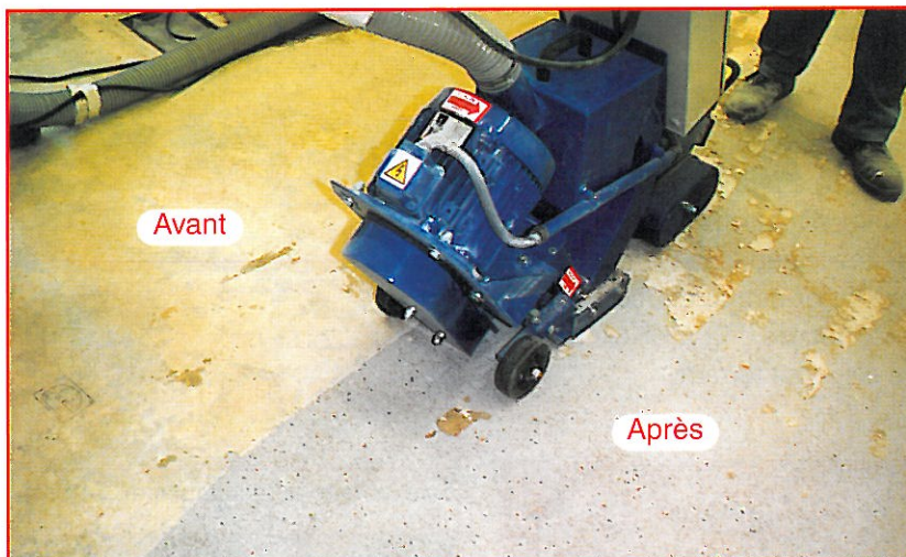
Enlèvement des colles d'un ancien revêtement
