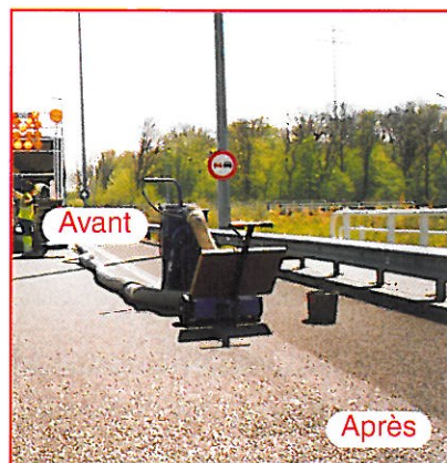
Effacement du tracé d'une voie
